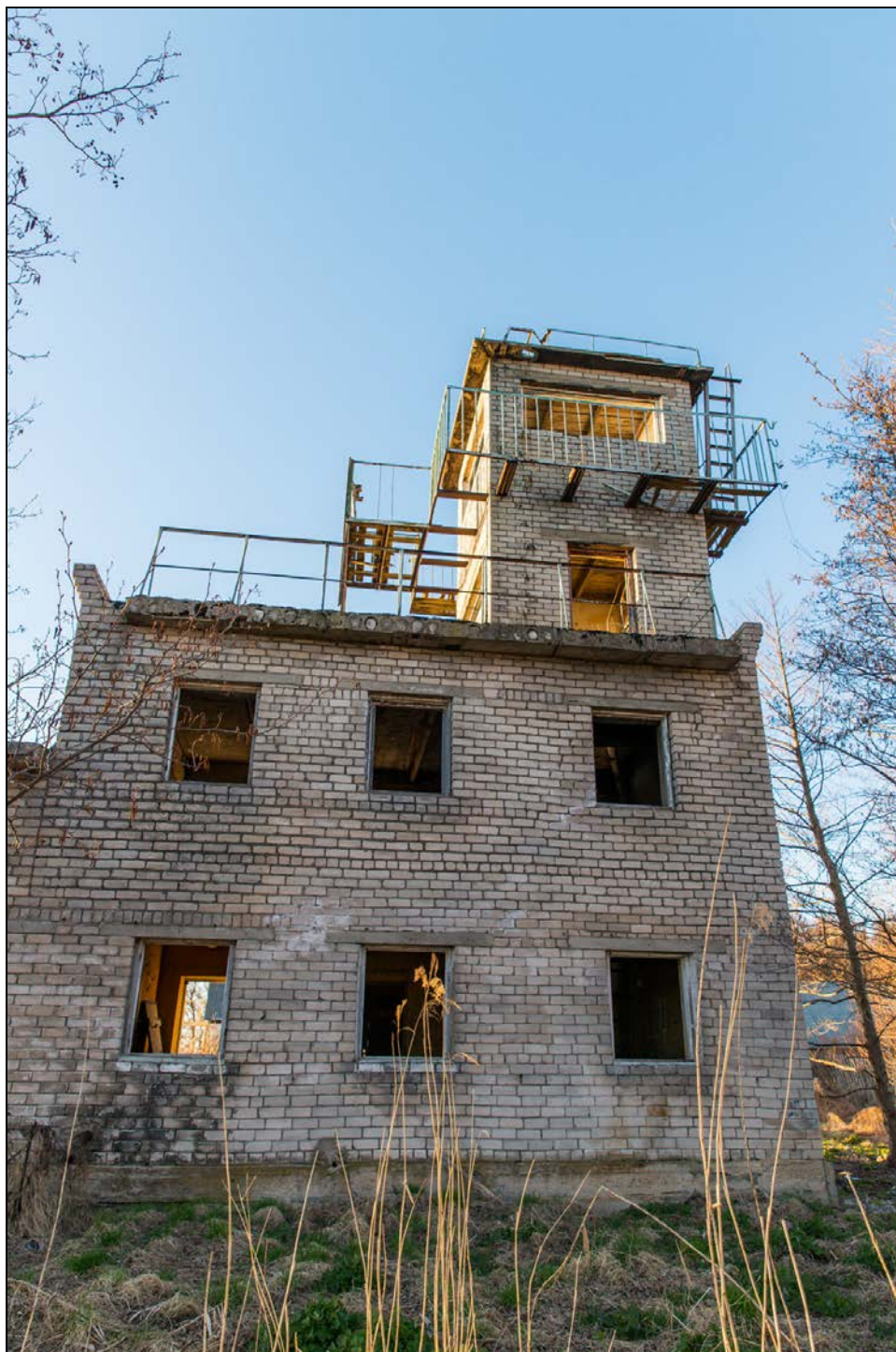
Foto 5 (). Leesi tehnilise vaatluse post on neljakorruseline. Foto Mart Mõniste 23.04.2014.
