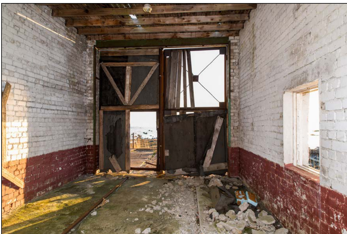
Foto 11 (480). Leesi tehnilise vaatluse post. Prožektoriruum. Foto Mart Mõniste 23.04.2014.
