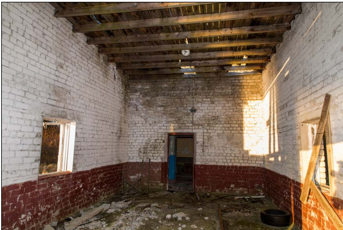
Foto 10 (478). Leesi tehnilise vaatluse post. Prožektoriruum, Foto Mart Mõniste 23.04.2014.
